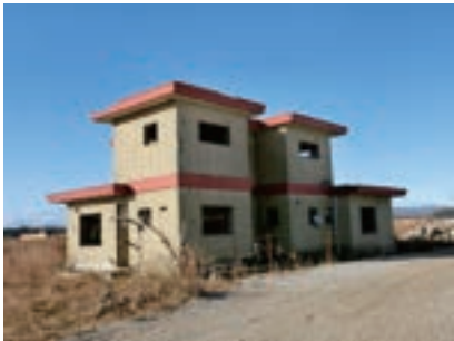
地震・台風・津波・火災に強い 日本の補強CB造 (写真:石山祐二)
